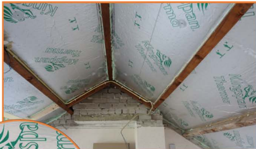
Stap 2: PIR platen aanbrengen
