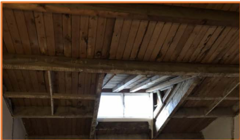
Stap 1: Stucwerk verwijderen
