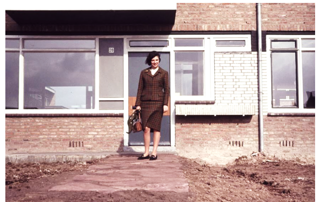
Foto van de opleving van de Neumannlaan 28 (woningtype II), bron Jan Sluijter
