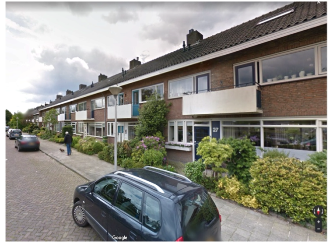
Een langgerekt gevelbeeld (type III) met woningbrede kozijnen om de lengte van de woningen en straat te benadrukken.
